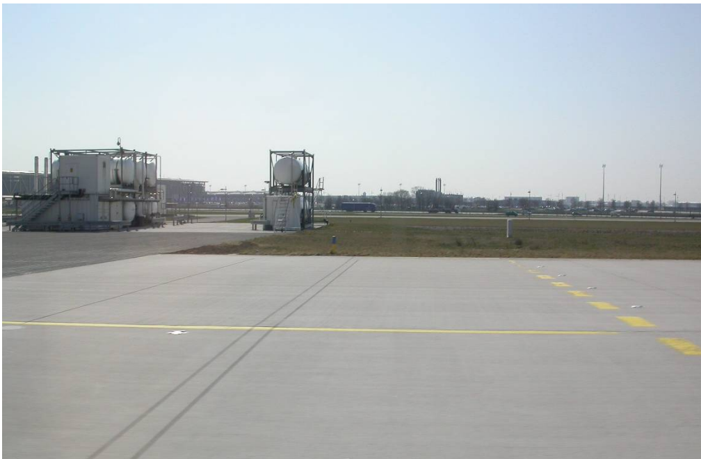
Enteisungslager Nord Flughafen Leipzig Halle
